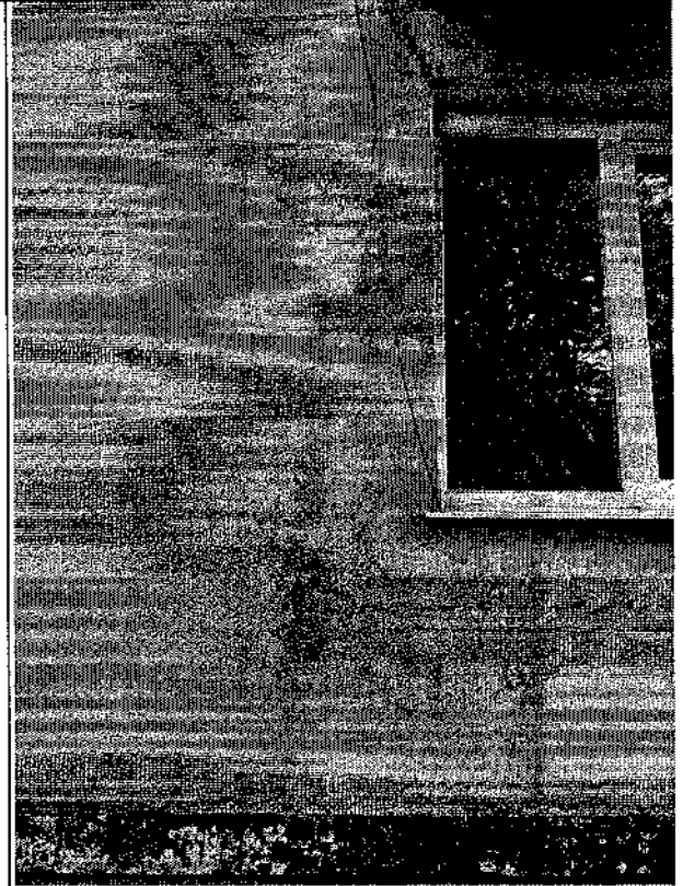
Фото 11, 12. Локальные разрушения защитного штукатурного слоя стены под окнами 1 этажа здания. Дефект эксплуатационного характера. Вызван промерзанием насыщенной влагой кладки и дальнейшим её разрушением, а также внешними механическими воздействиями (включая атмосферные осадки).
